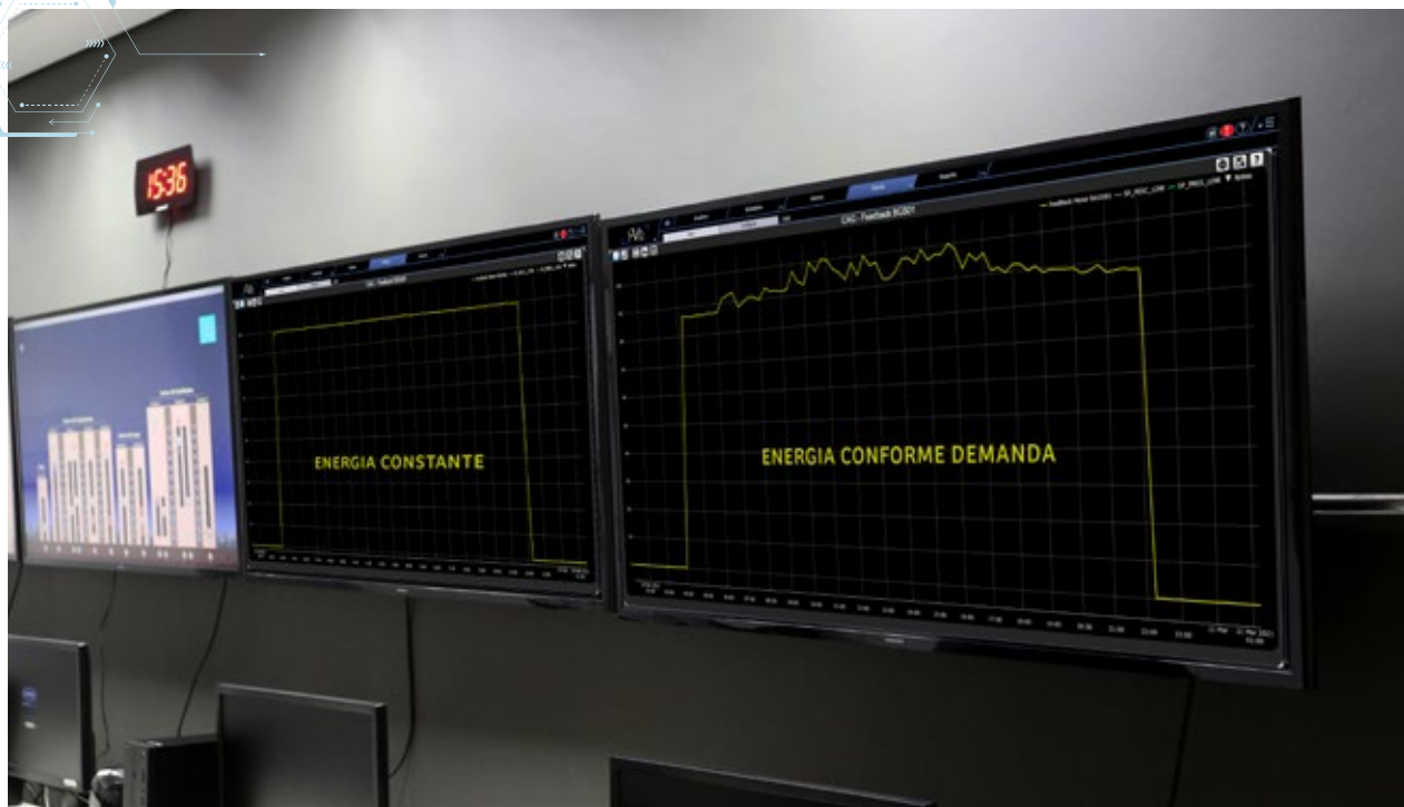
CCO mostra a economia de energia com o monitoramento do sistema de ar-condicionado do Centro de Facilidades do Minas I
