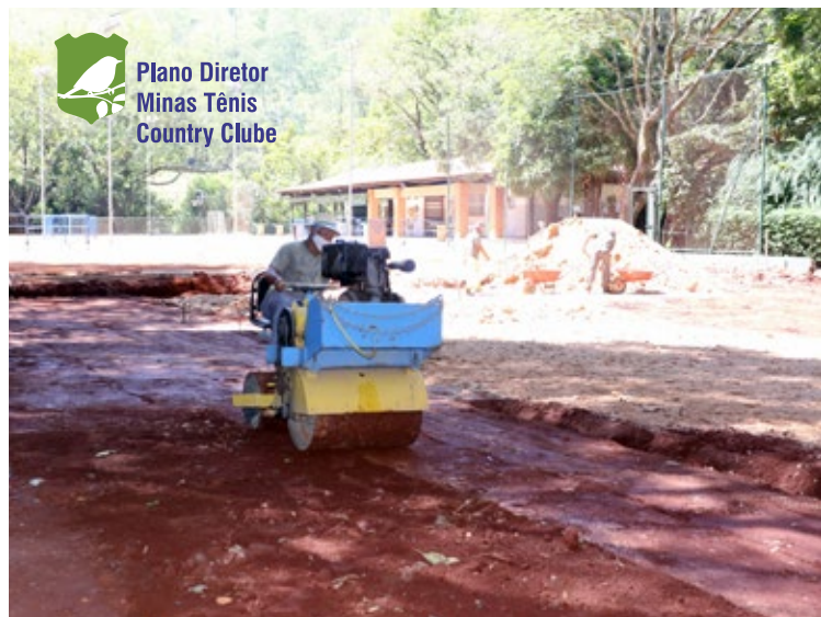
A construção das novas quadras de areia está em ritmo acelerado
