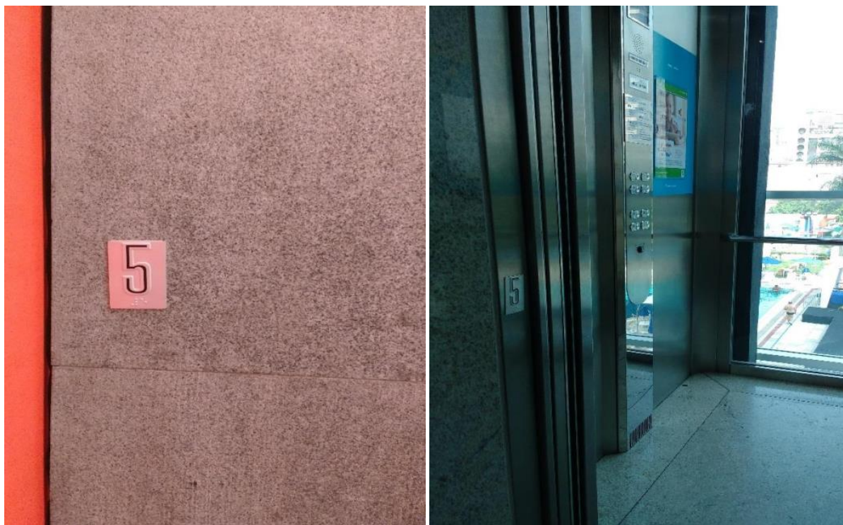
Sinalização tátil externa dos elevadores.
