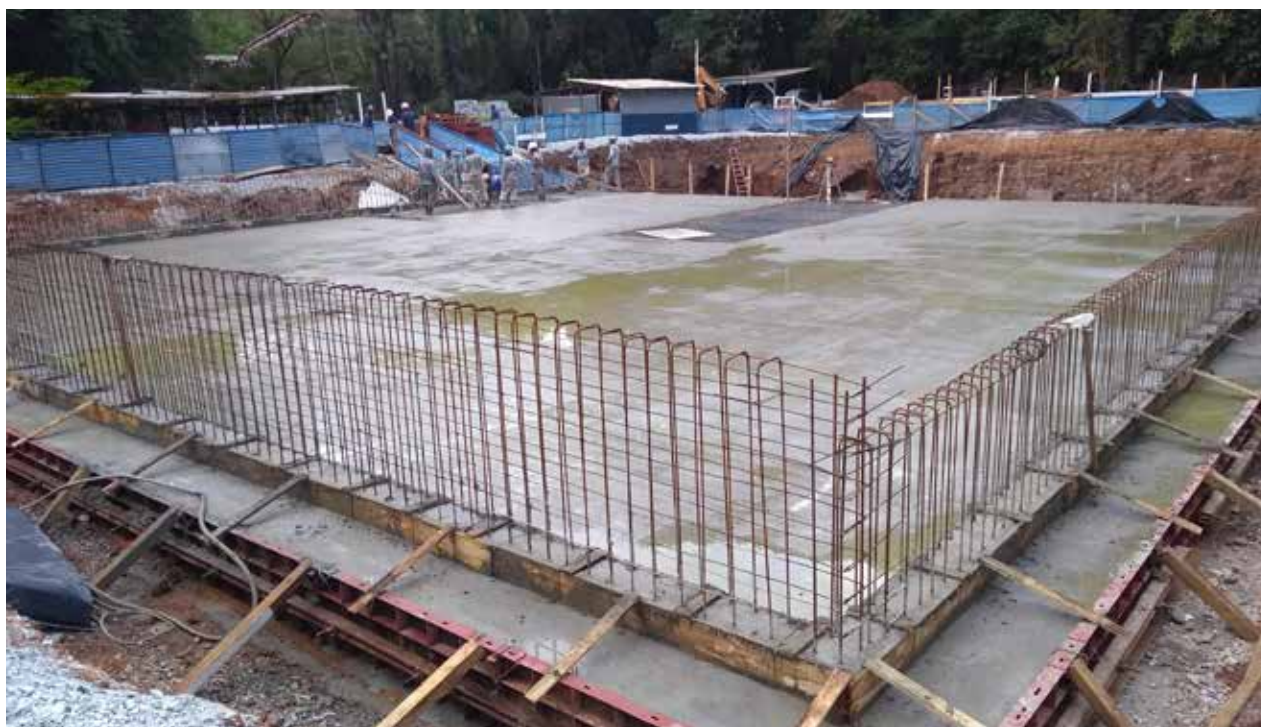
Canteiro de obras: em primeiro plano, a área em que será erguido o prédio da Lanchonete
