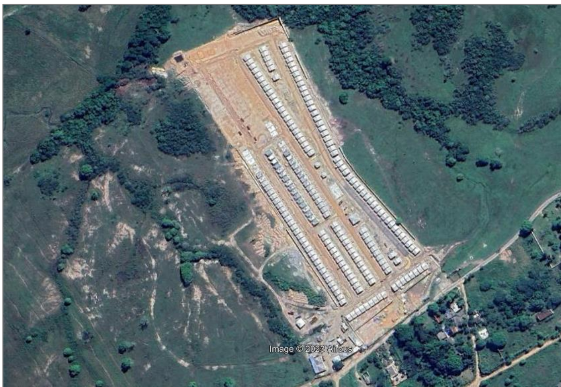
Imagem 20: Imagem de satélite da construção de condomínio vizinho ao empreendimento em questão.
