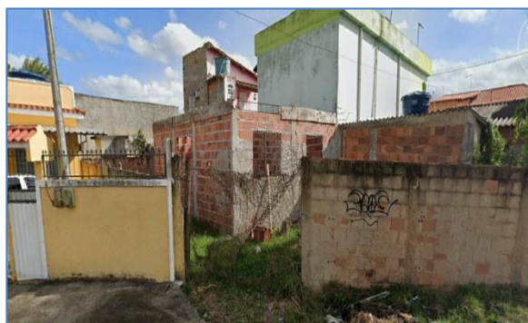
Figura 4- M6A – Rua Arlindo Chaves - Outeiro das Pedras – N:7483215.704, E:718211,886
