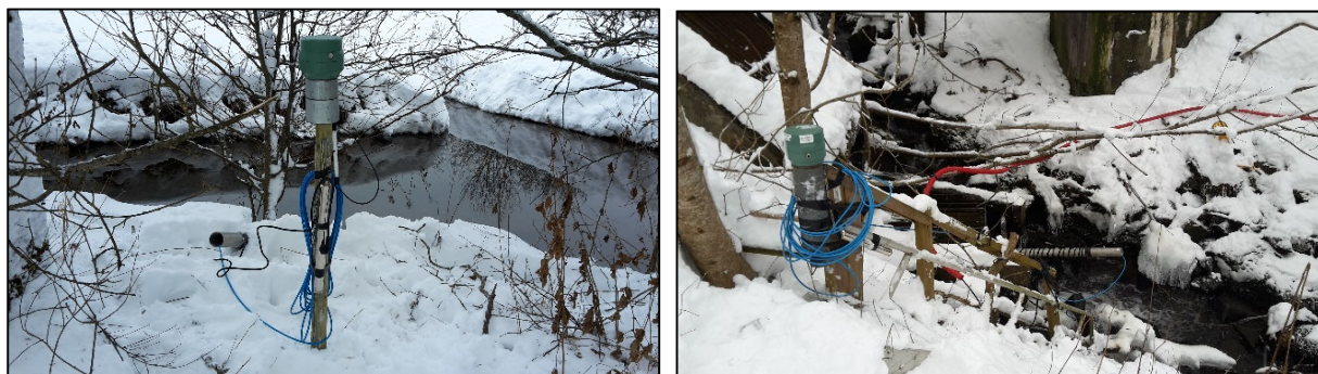
Figur 2.10. Automatisk multiparametersensorer installert i felt i Bølerbekken oppstrøms (BØKL-O) til venstre, og Bølerbekken nedstrøms (BØL-N) til høyre.
