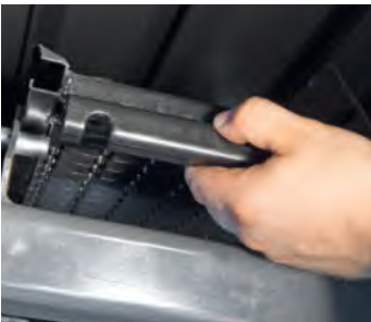
Démontage des grilles
