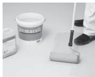
Ondergrond gronderen en randstroken aanbrengen
