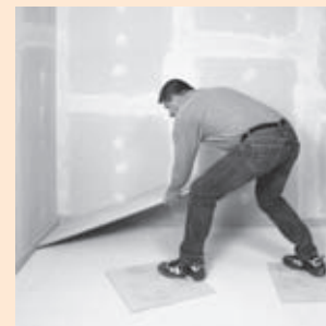
Leggen van de vloerelementen
