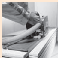
Afzagen van lipllas voor eerste rij platen
