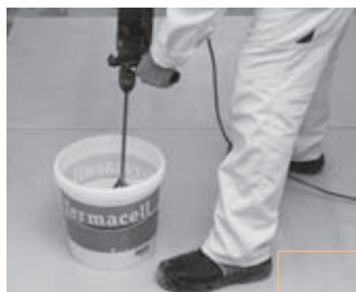
In een schone emmer mengen 6,5 l water per 25 kg
