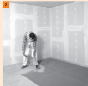
2 Het FERMACELL Honingraatelement met FERMACELL Honingraatkorrels vullen
