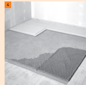
4 Het FERMACELL Honingraatsysteem afreien
