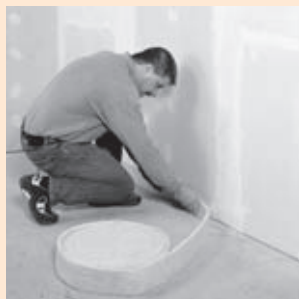
Randisolatiestroken aanbrengen
