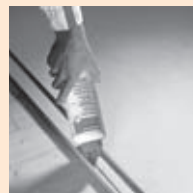
Aanbrengen lijm
