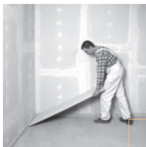
De FERMACELL Vloerelementen leggen
