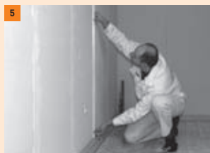
5 De storthoogte controleren
