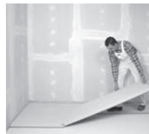
Leggen van de vloerelementen
