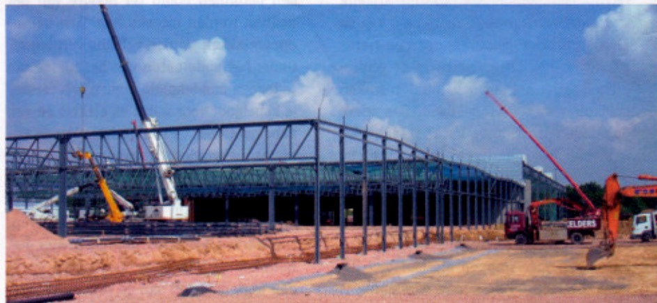
De gebouwen zijn in hoofdzaak metaalskeletten met een wandbekleding van geprefabriceerde betonpanelen (onderaan) en metaal (bovenaan).
