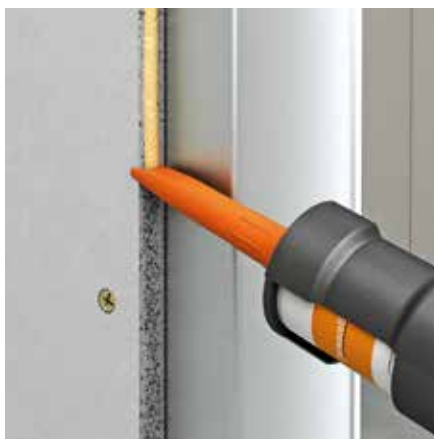
fermacell lijmvoeg – voegbreedte: 0.5 - 1 mm
