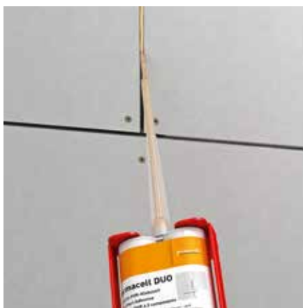
Achteraf verlijmen door fermacell DUO Voegenlijm – voegbreedte: 5 mm
