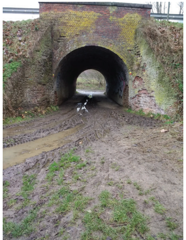
Foto 1-6: tunneltje is verhard en voldoende breed en hoog maar modderig in najaar en winter
