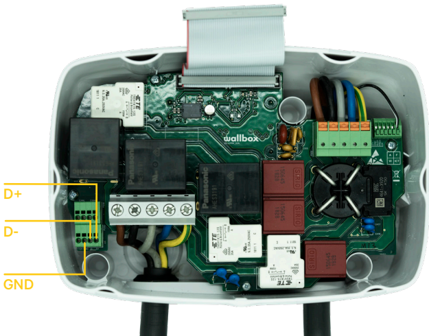
Fig. A1.6 Installation der Verkabelung in einer Commander 2 Wallbox
