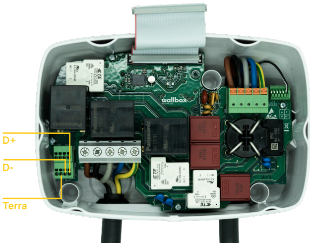
Fig. A1.6 Instalação de cabos num Commander 2 da Wallbox
