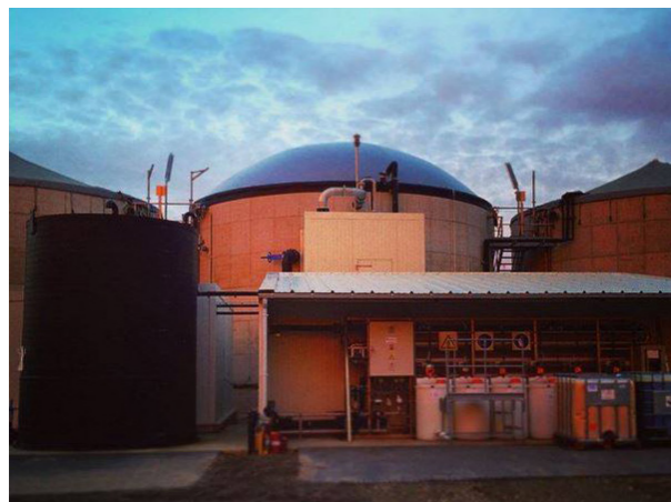
De anaerobe waterzuiveringsinstallatie in Hooge Maey
