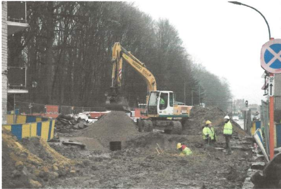
Op de hoek van de Grote Baan en de Nieuwstraat zijn de werken volop aan de gang. - Foto Mozkito
