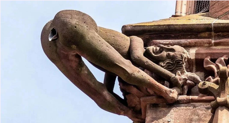
(m) Waterspuwer op de gevel van de kathedraal van Freiburg (D), 13de eeuw.
