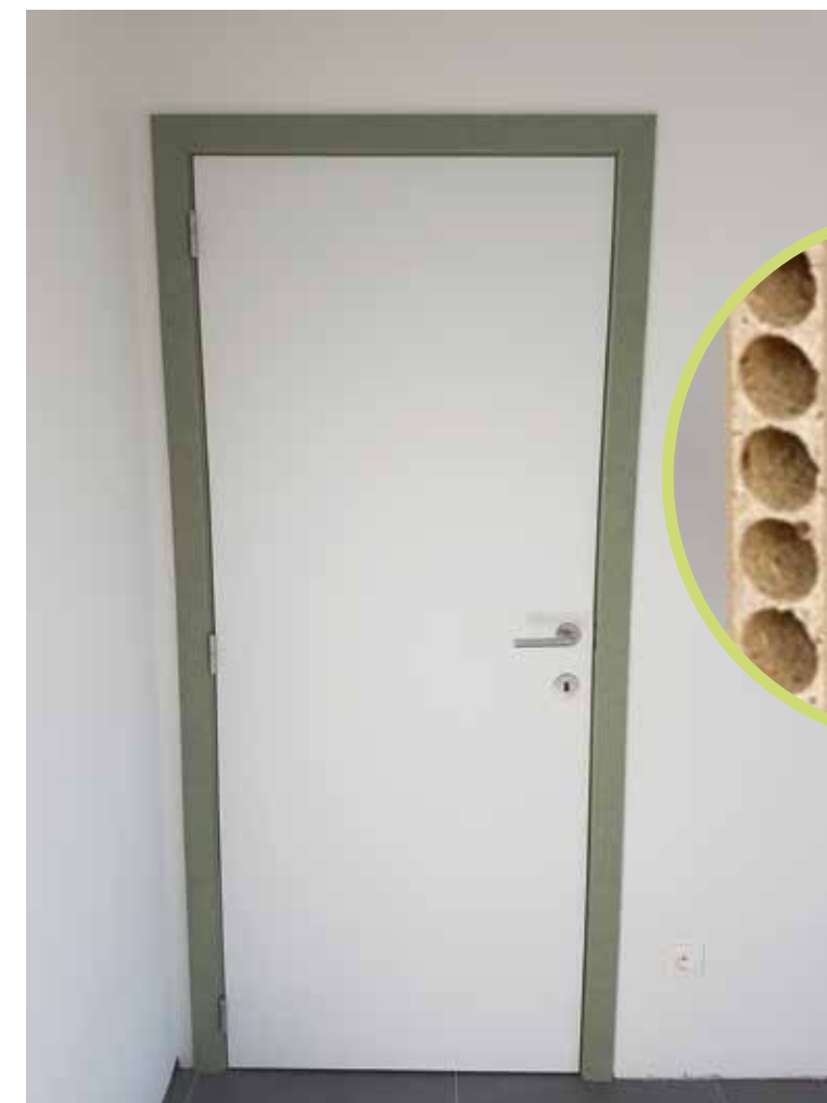
Doorsnede tubespaan deurblad
