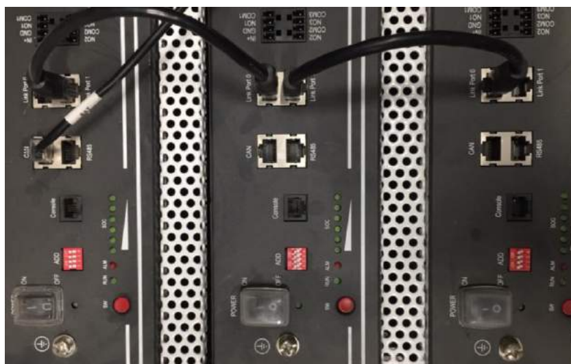
Figura 11 - Collegamento del cavo di comunicazione tra tre batterie Pylontech
