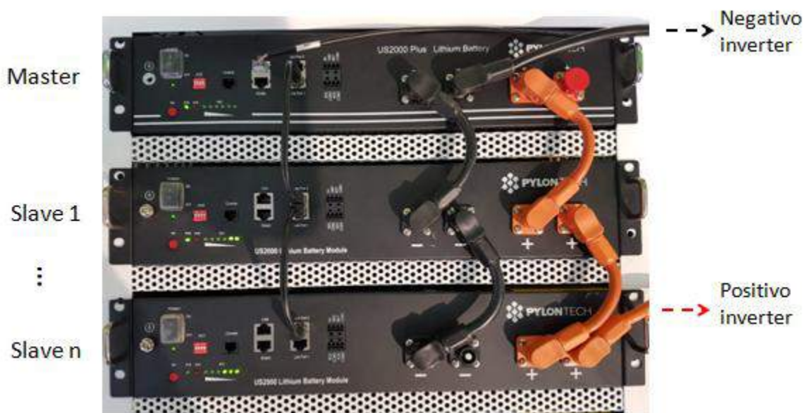
Figura 10 - Collegamento di tre batterie Pylontech in parallelo
