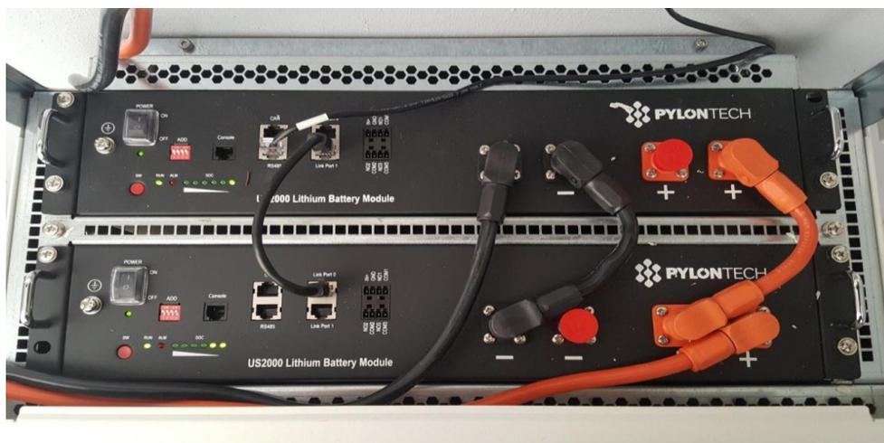
Figura 1 – Vista superiore di due batterie installate all'interno dello Storage Box
