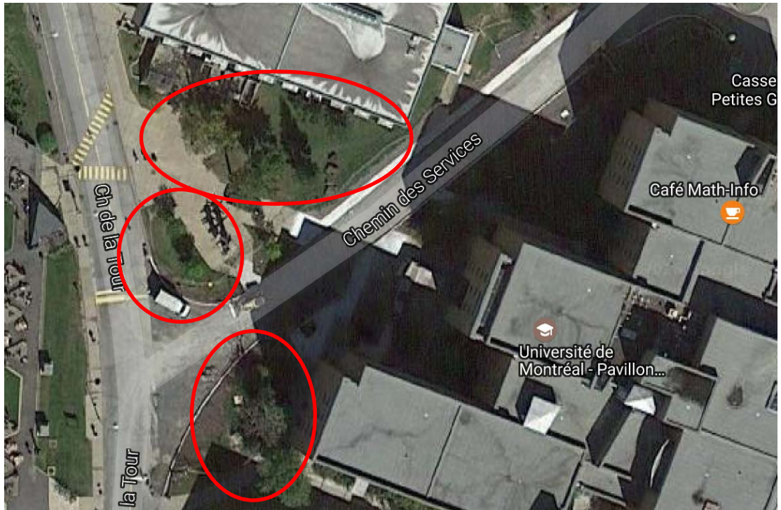
Figure 1 : Vue aérienne des espaces verts relativement plats pouvant servir de rétention pour le chemin des Services
