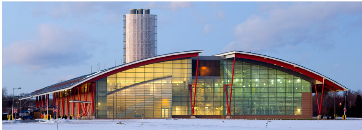
CENTRAL HEATING PLANT, UMA
