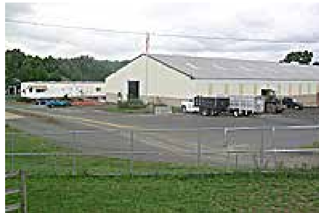
UMA WASTE MANAGEMENT FACILITY
