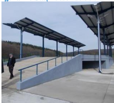
Figura 7-8 Stații deschise de transfer
