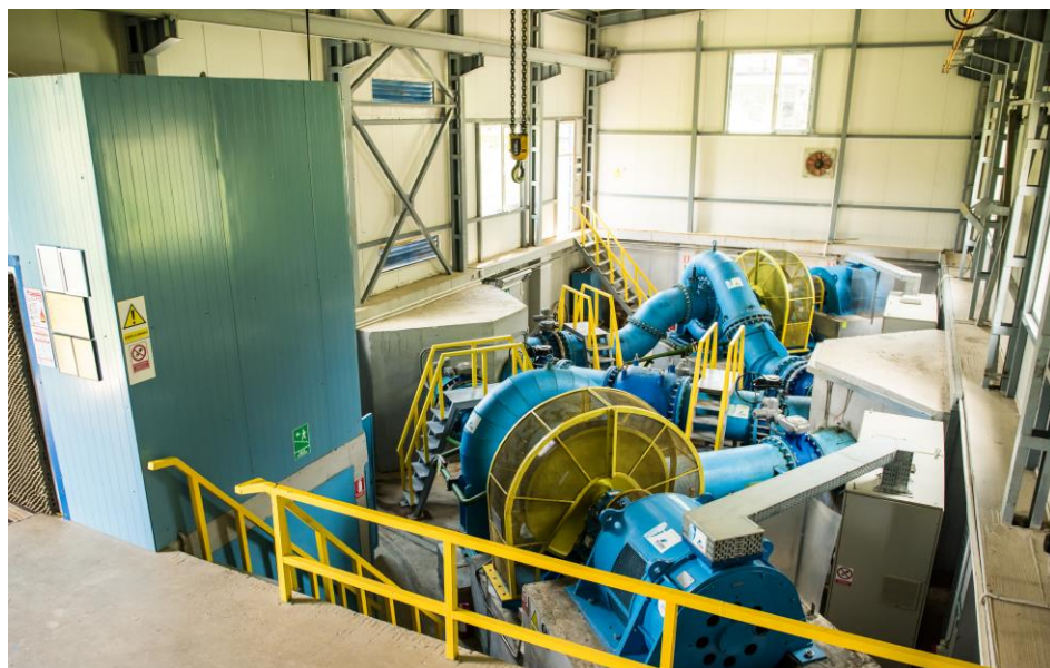
Microhidrocentrala Companiei în aval de barajul Tarnița
