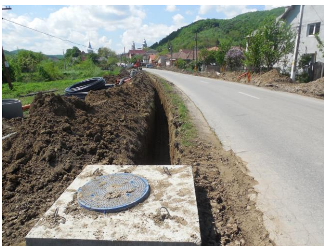
înființare de rețele de canal în Dej
