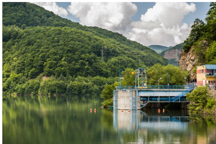
Priza de captare a apei din lacul Tarnița
