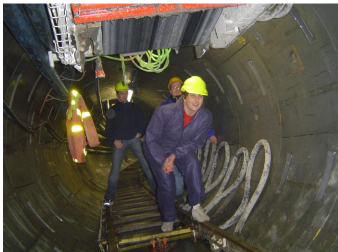
Canal colector Iașilor-Bd.N.Titulescu realizat prin săpătură în scut
