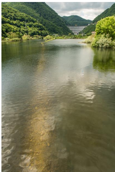
Aducțiunea subacvatică Someșul Cald
