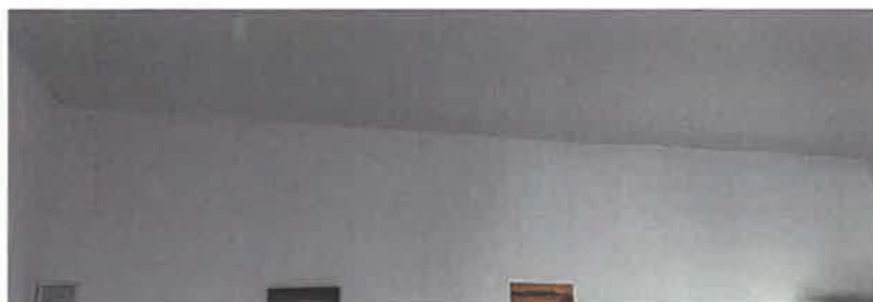
Foto 19 – Stare actuala pereti si planseu – parter – fara fisuri (07.01.2021)
