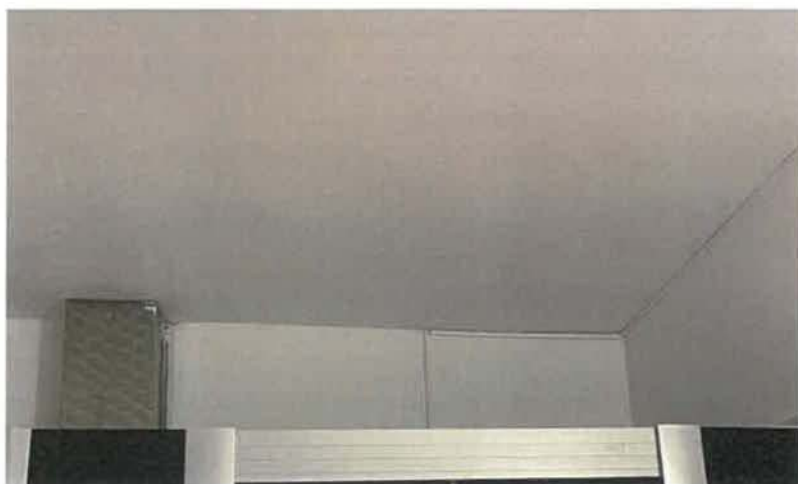
Foto 18 – Stare actuala pereti si planeu – parter – fara fisuri (07.01.2021)
