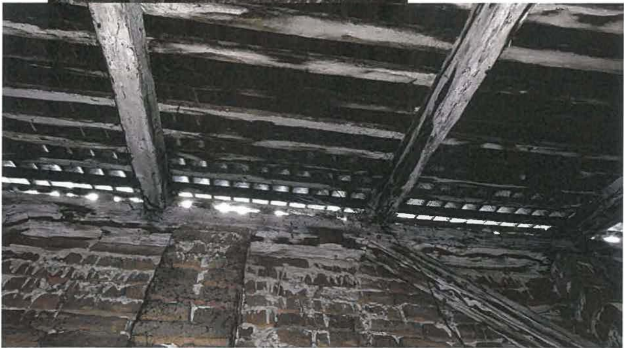
Foto 15 – Fisuri identificate in perete mansarda (07.01.2021)
