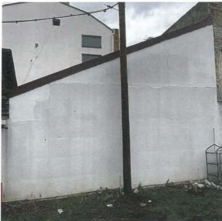
Foto 23 – Calcan comun – strada Aviator Bădescu nr. 1B (07.01.2021)
