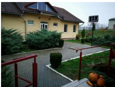
Locuințe Protejate Cățcău
