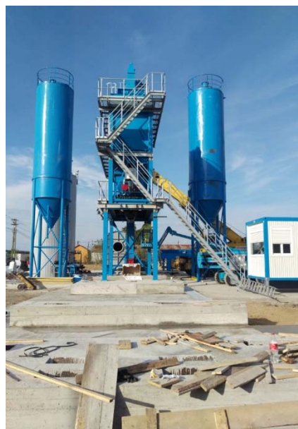
Decofrare fundații și echipamente stație asfalt
