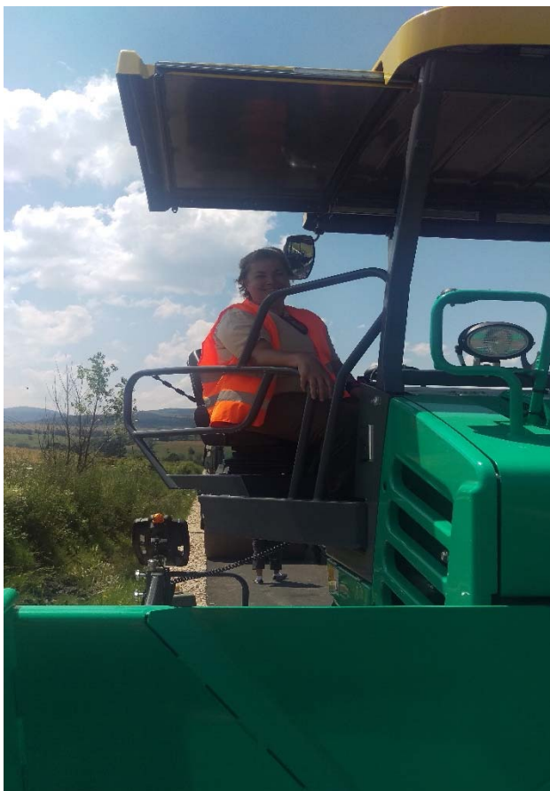
Figura 2: Tronson experimental DJ108C și punere în funcțiune repartizator asfalt
