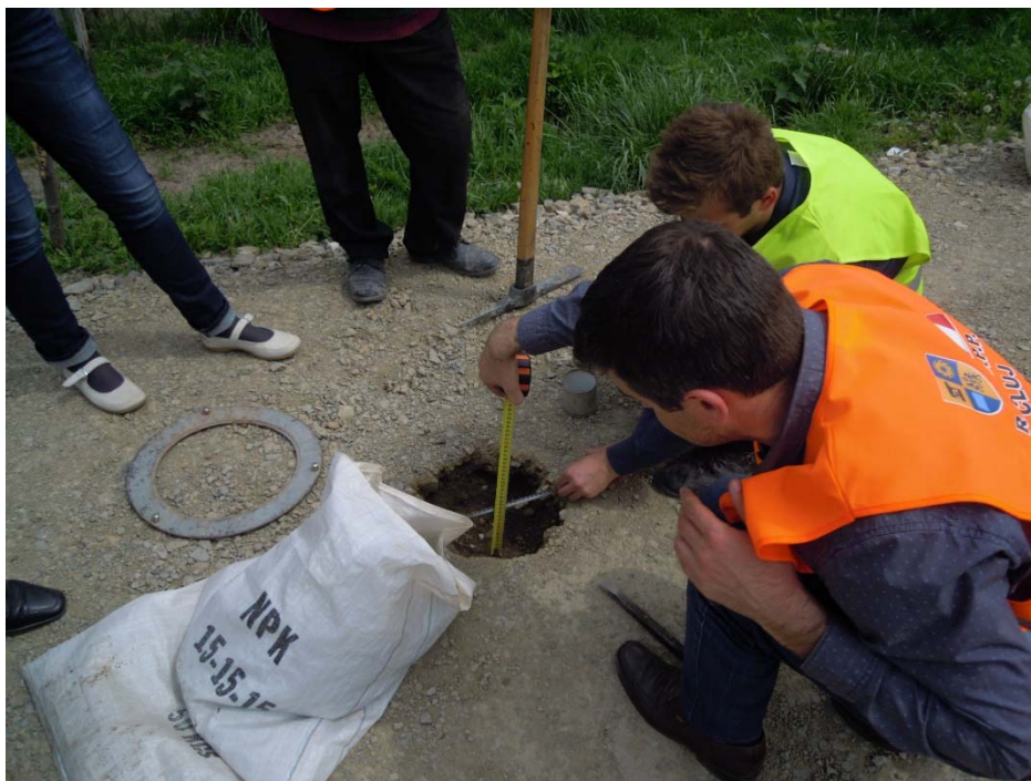
Figura 5: Verificare grosime strat și grad de compactare: DJ 161 H Suatu
