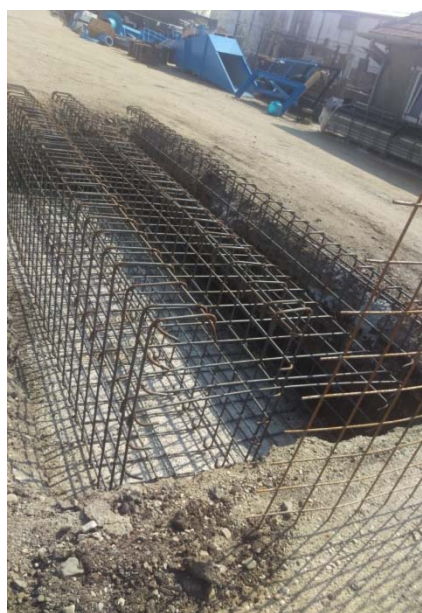
Armare fundație stație asphalt
