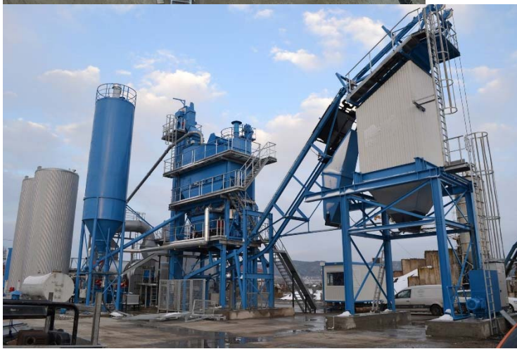
STAȚIE ASFALT BENNINGHOVEN ECO 100
