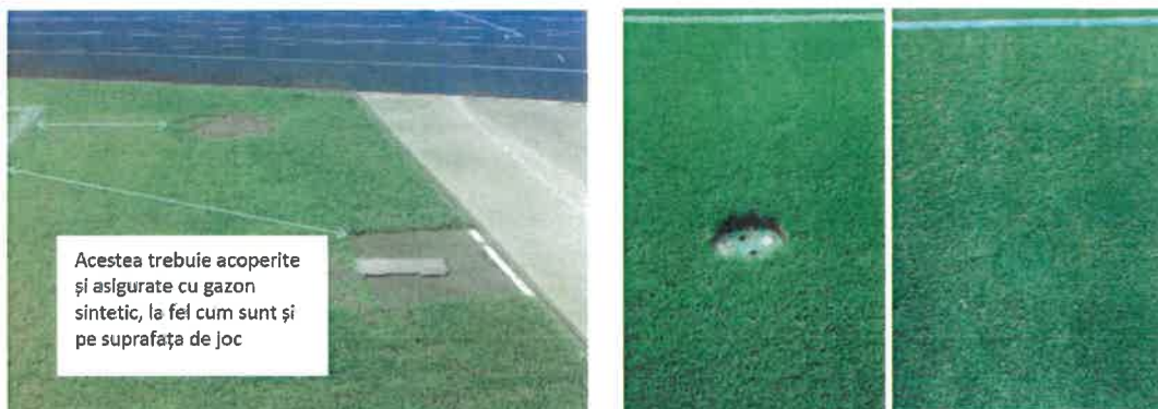
Casete de acces și serviciu în zona de siguranță din jurul terenului de joc (Fig. 28 - Ghidul UEFA privind calitatea terenului - Întreținerea terenului cu gazon natural – ediția 2018, p. 37)
