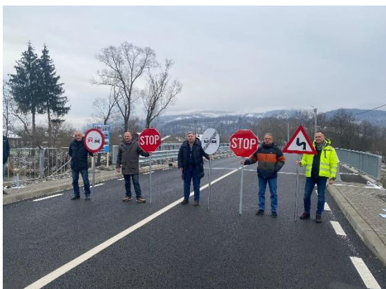
Finalizare lucrări modernizare „Drumul Apusenilor”
