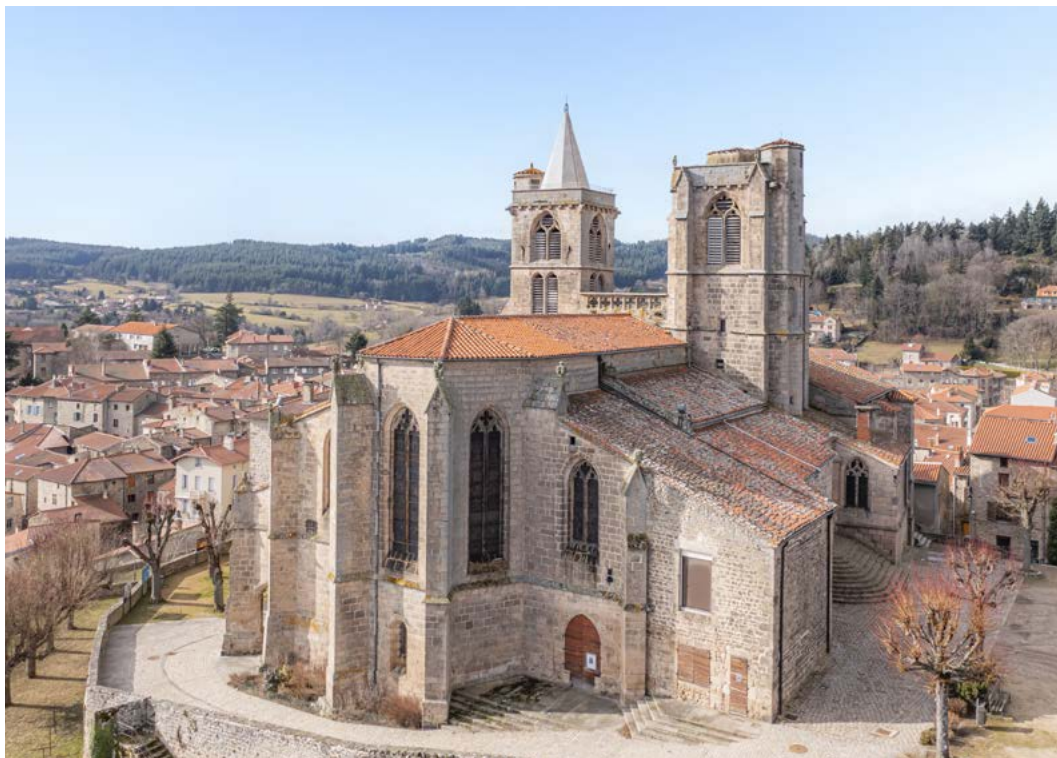
Collégiale de Saint-Bonnet-le-Château © Fondation du patrimoine – Myphotoagency – Jeremy Penel
