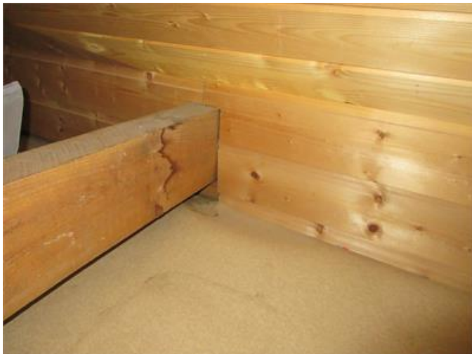
Missfärgning golv/stödben i sidovind
