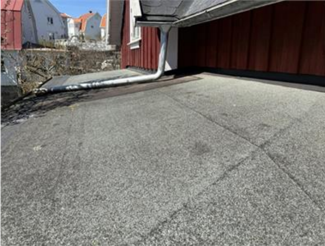
Bilden visar vy av tak (veranda).
