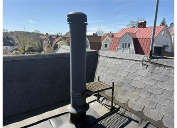
Bilden visar vy av tak (huvudbyggnad).
