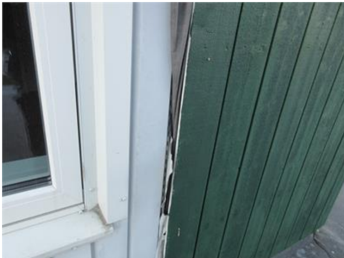
Otättheter mellan trä och plastfasad
