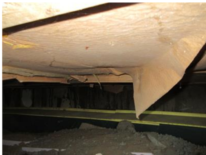
Bild visar krypgrund under huset på framsidan byggnaden
