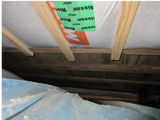
Utbytt samt ej bytt bjälklag i krypgrund
