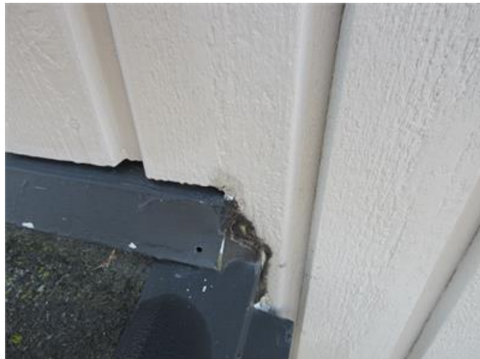
Mjukfog som släpper mellan förrådstak och husfasad
