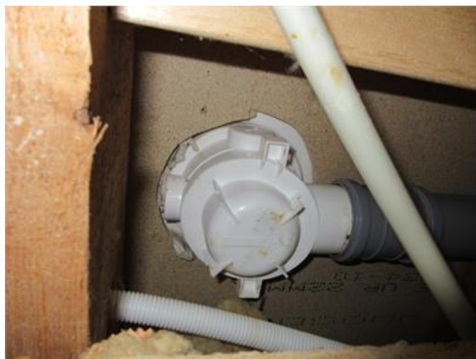
Golvbrunn till badrum. Bild tagen från slitsluckan
