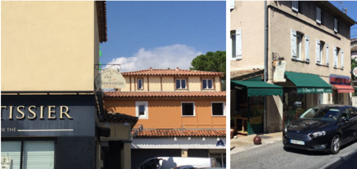
Enseignes perpendiculaires au mur bien intégrées, réalisées en fer forgé, Mougins, Aout 2018.
