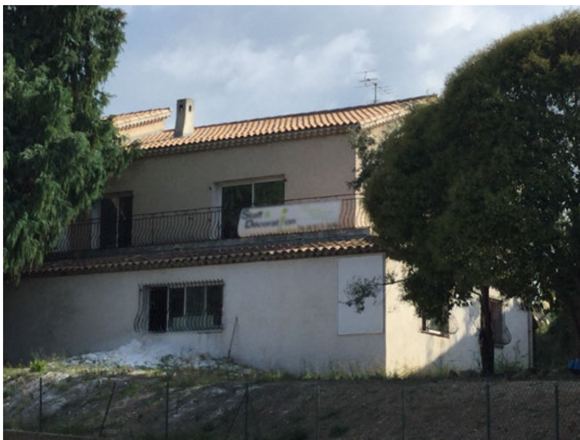
Enseignes sur balcon masquant le bâtiment, Mougins, Aout 2018.
