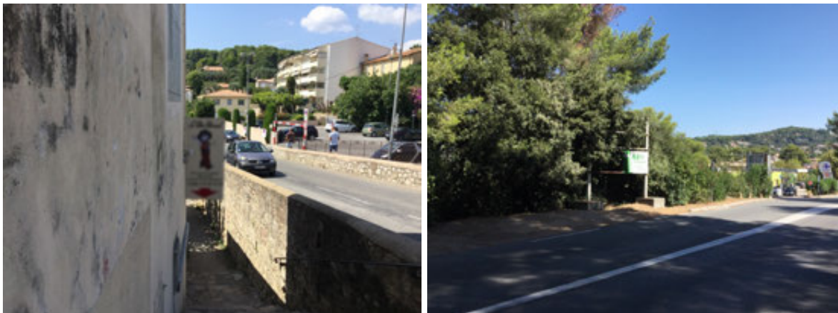
Une publicité et/ou préenseigne installées perpendiculairement au mur et un dispositif en mauvais état d'entretien, Mougins, Aout 2018.
