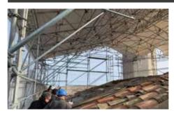
Le parapluie installé au-dessus du centre de la photographie permet de poursuivre les travaux d'aménagement, quelle que soit la météo.
