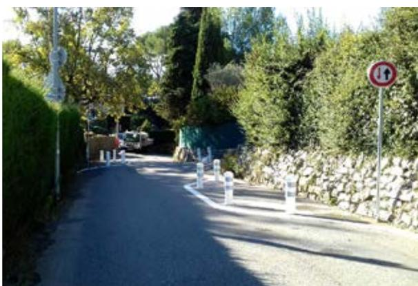
• **Chemin Pablo Picasso** : Mise en place de plots pour limiter le tonnage et le gabarit des véhicules empruntant la voie tout en réduisant la vitesse.
