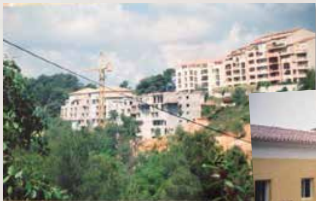
Fin de chantier, dans les années 2000
