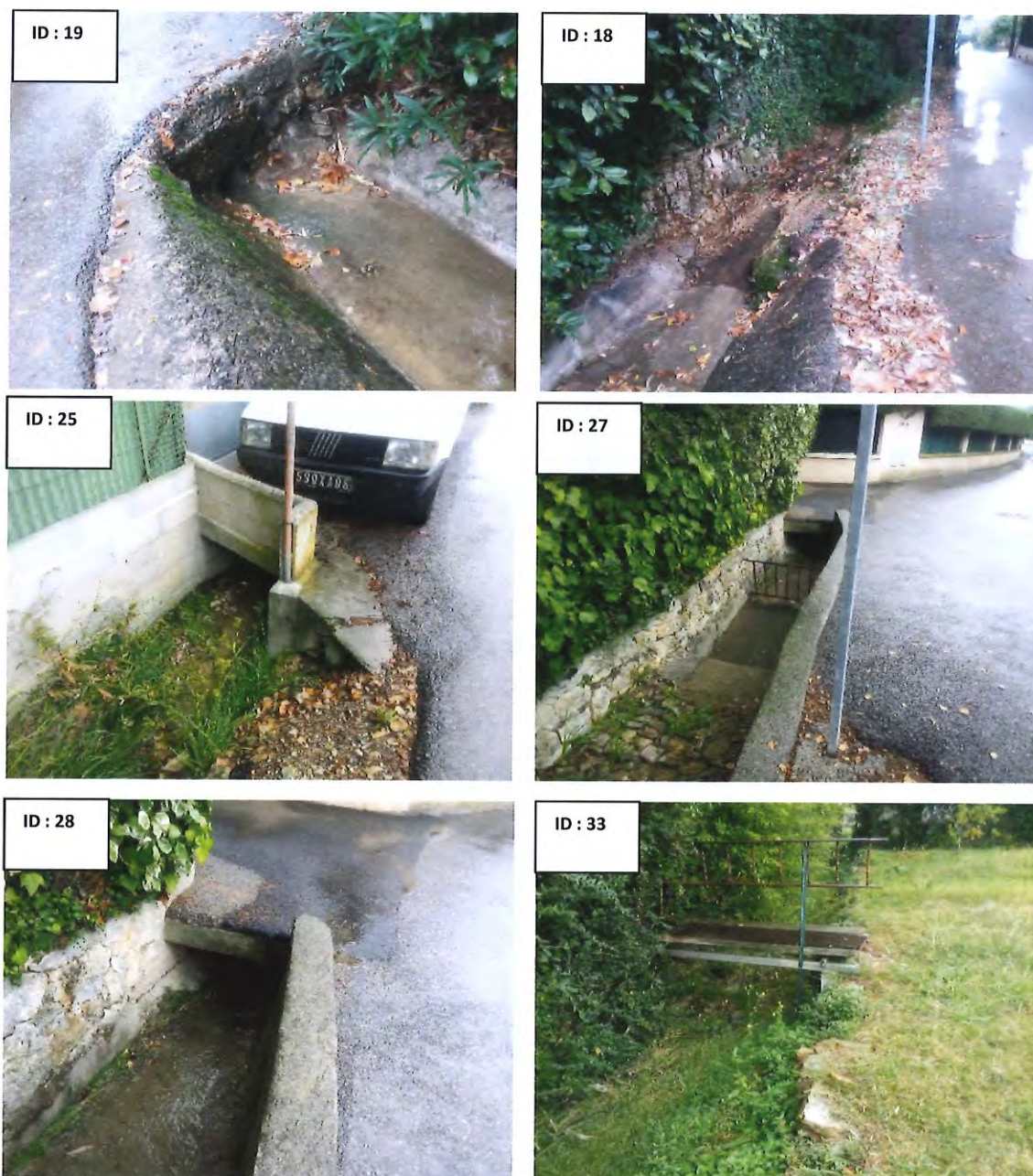
Figure 19 : Photographies le long du linéaire amont du Colombar – secteur Camp Lauvas issues des investigations terrain sur le Colombar. Succession de passages enterrés et à surface libre
