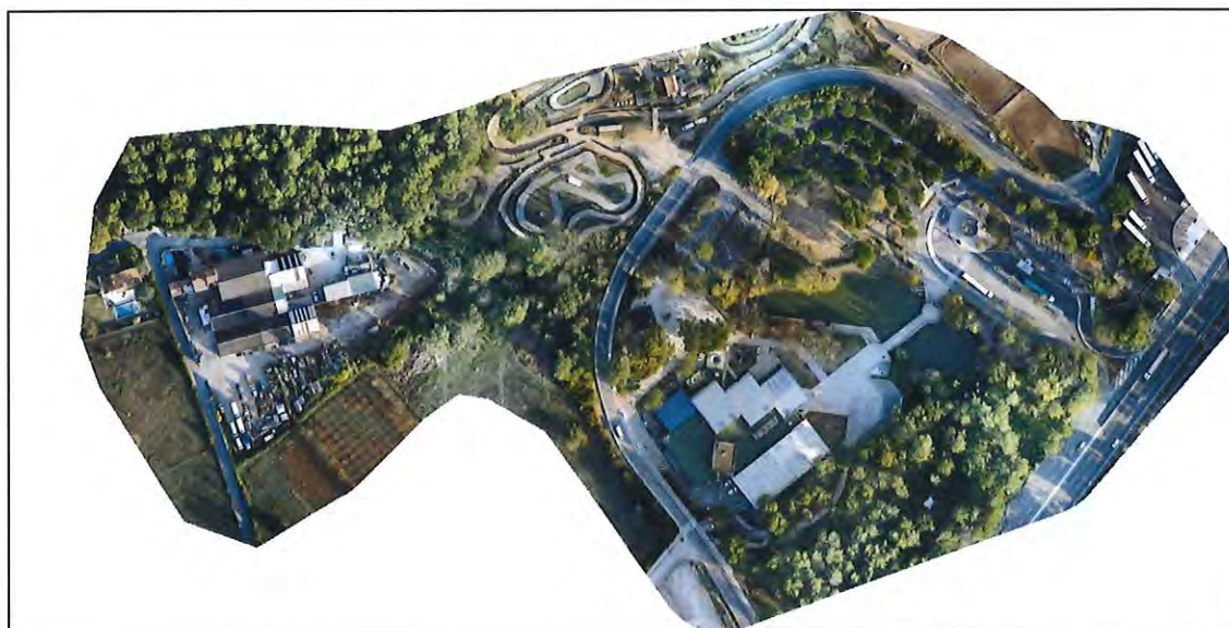
Figure 35 : Vue globale du relevé photogrammétrique sur Bréguières
