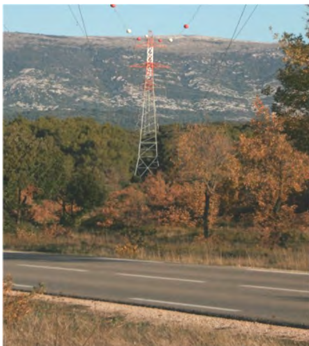
Superposition entre linéaires : route et ligne électriques
