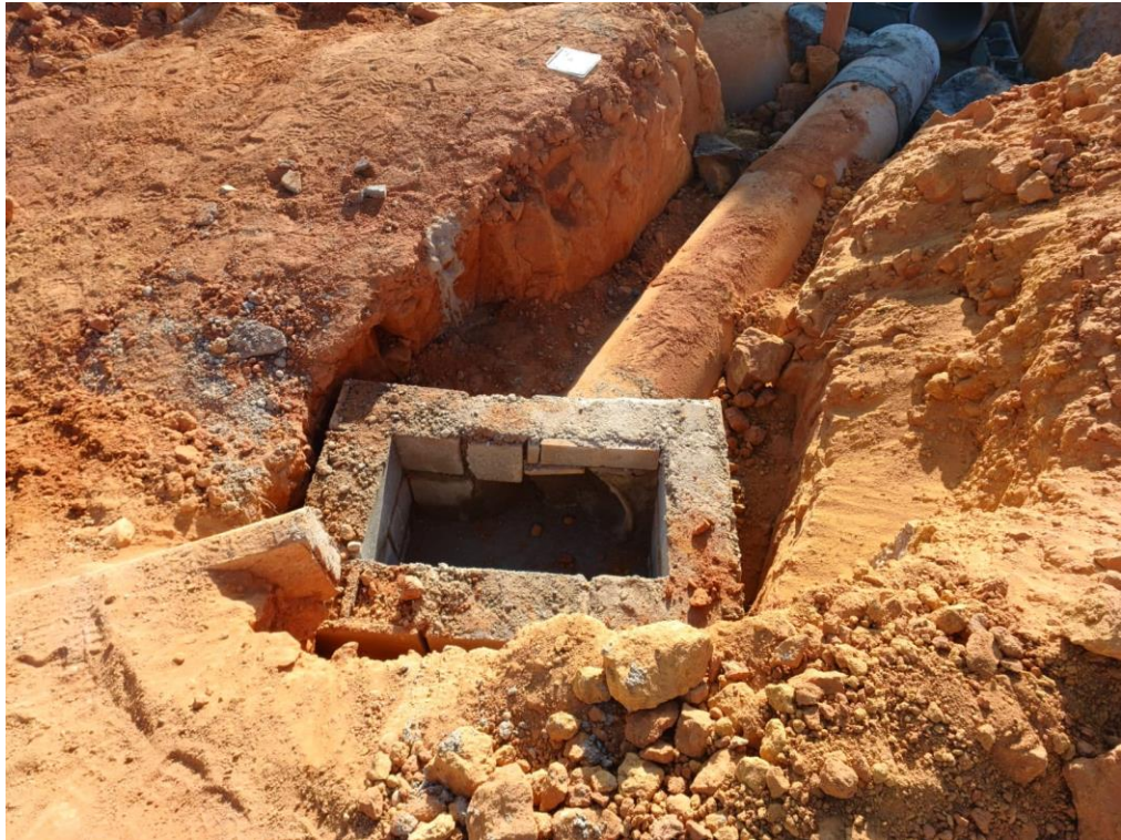
Figura 3- Instalação de Tubo de Concreto para drenagem profunda e execução de caixa para instalação de Boca de Lobo na Rua 03.
