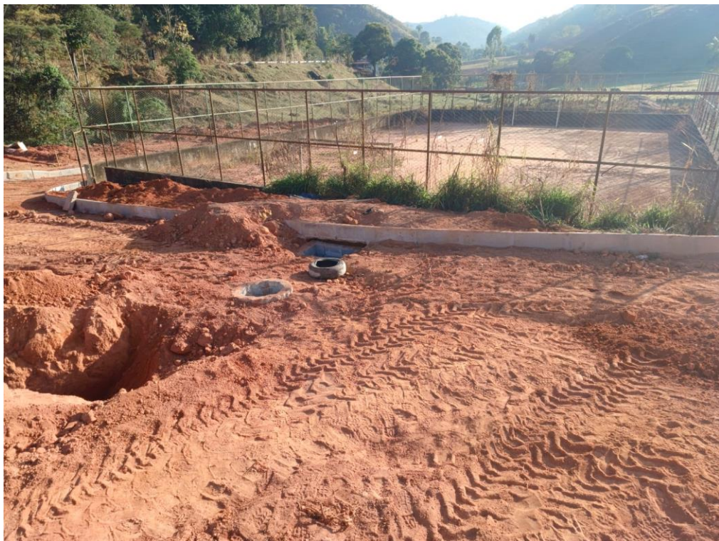
Figura 6- Poço de visita e caixa de bloco de concreto para instalação de boca de lobo executados no encontro da Rua 03 com a Rua 02.
