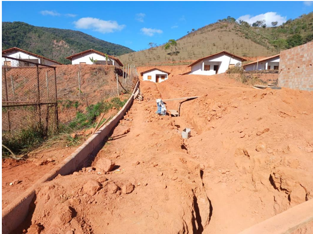
Figura 1- Escavação de vala para instalação de tubo de concreto para drenagem profunda. Rua 03.
