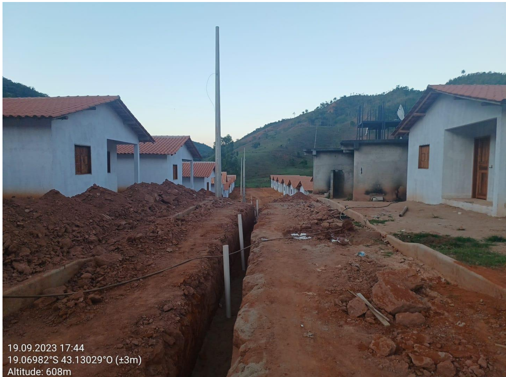
Figura 4- Execução de rede hidrossanitária na Rua 01.
