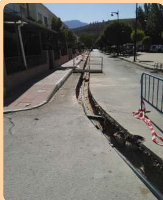
Estado de las obras de nueva canalización de aguas en Mogón. Actuación concluida en agosto
