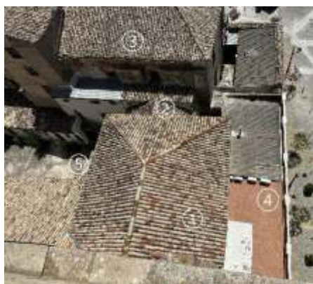
Vista aérea: 1) Capilla del Rosario; 2) Tejado de la cúpula del camarín de la Virgen; 3) Salones parroquiales (antiguas escuelas graduadas); Casa sacerdotal; 5) Patio de la iglesia.
