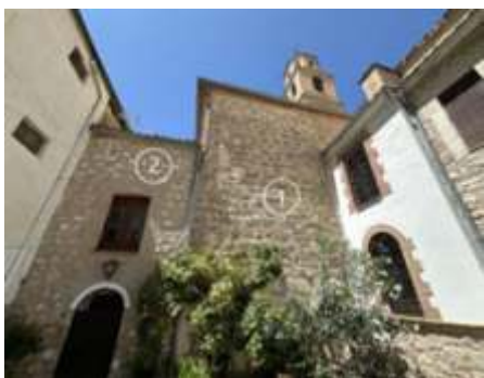
Vista exterior: 1) Capilla del Rosario; 2) Habitáculo de la cúpula del camarín de la Virgen, revestido con estructura de piedra de época posterior.
