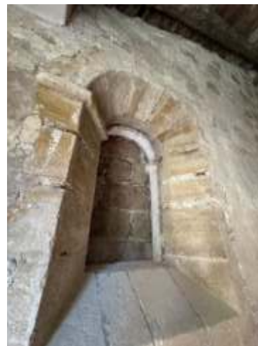
Ventana cegada de la capilla.
