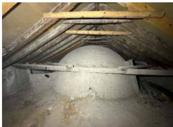
La bóveda de la capilla con su armazón de madera.
