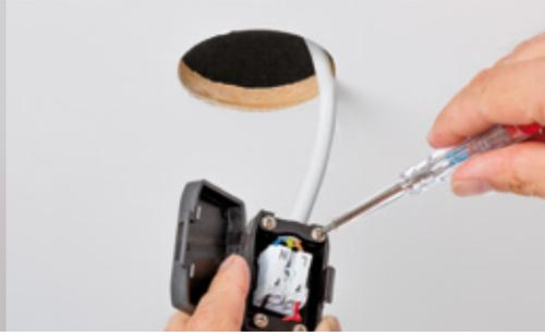
Einfacher Anschluss an der Schnellklemme
