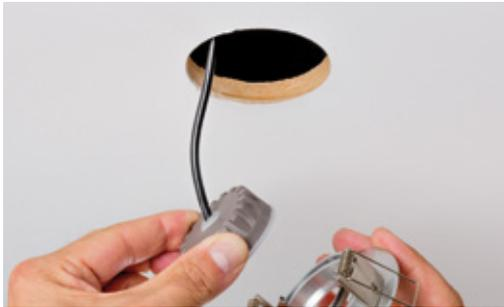
Coin einfach von hinten einsetzen –
