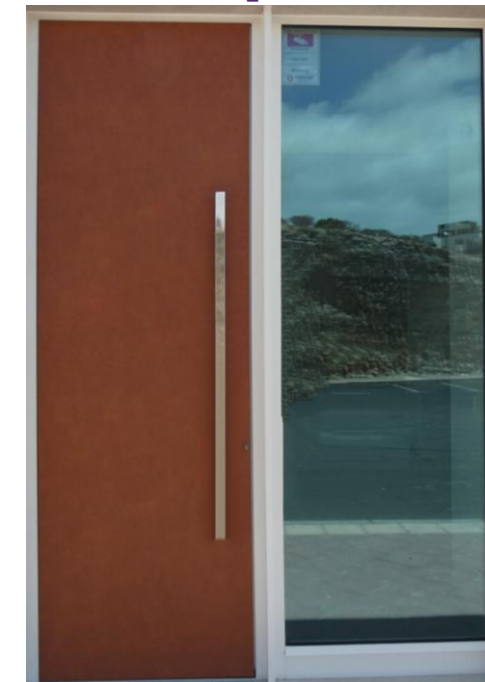
Zugangstür mit Trespa Meteon
