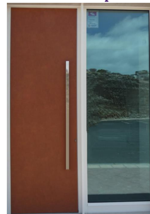
Porte d'accès avec Trespa
