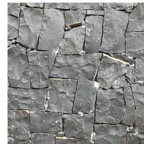
Mur en pierre basaltique
