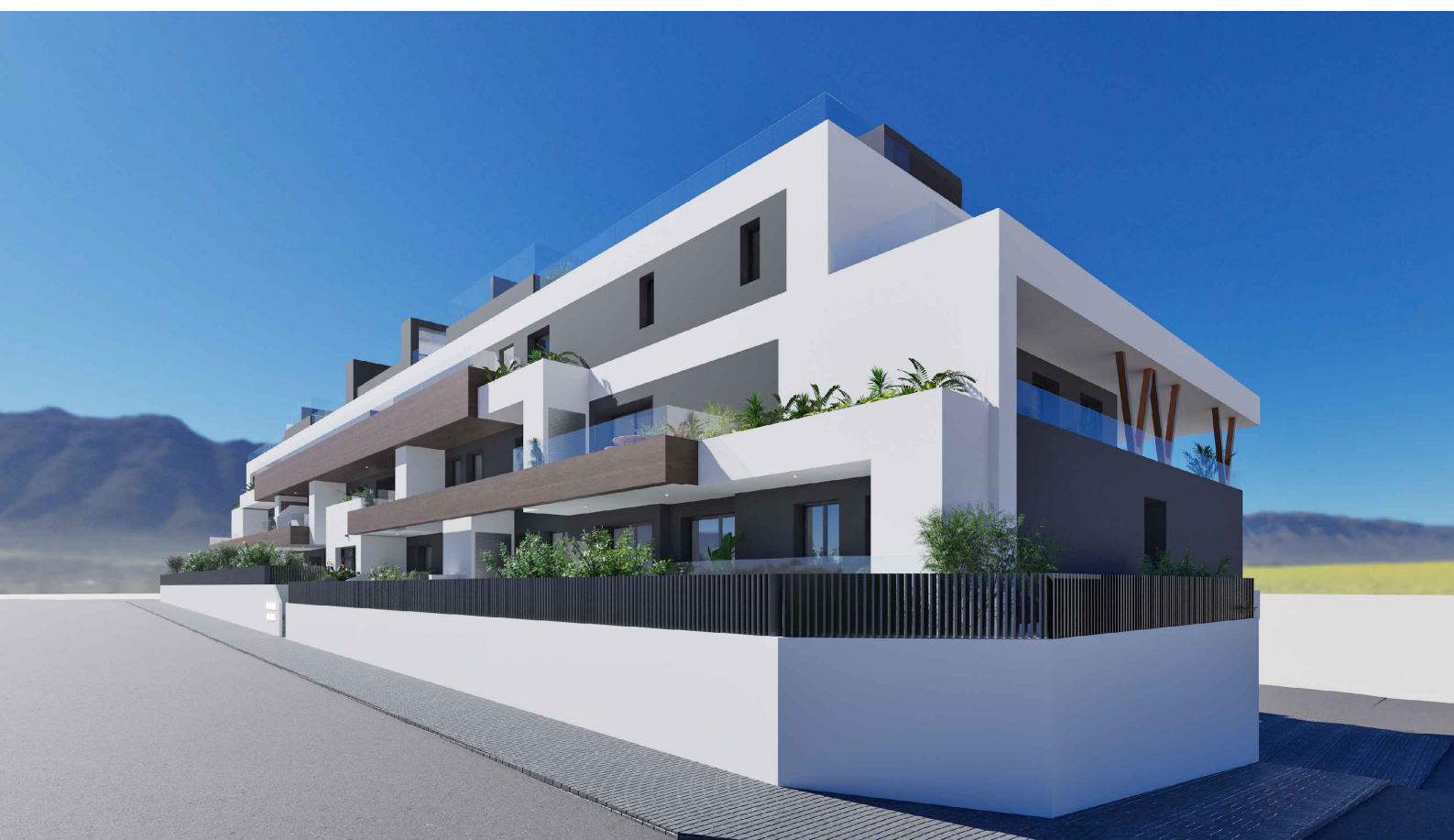
EDIFICIO WALDORF ASTORIA - 30 VIVIENDAS
