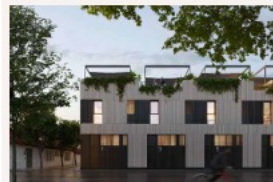
Vista de fachada.
