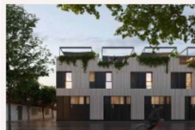
Vista de fachada.
