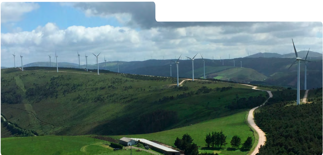
Planta de generación eólica en Ourense (Lugo)
