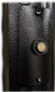
Button Photocell On Door (PCD)
